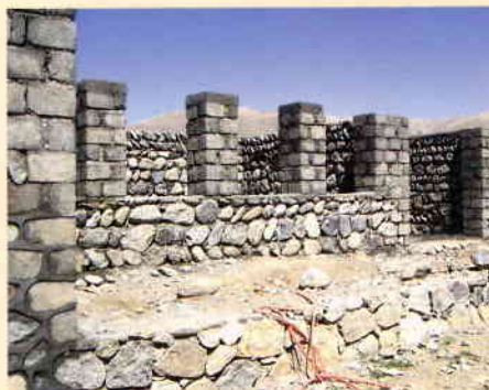
Die Grundmauern der neuen Schule stehen bereits.
