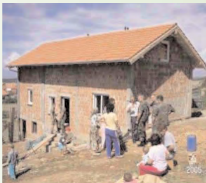
Den fertig gestellten Rohbau des neuen Hauses für die Großfamilie im Kosovo finanzierte Lachen Helfen e.V. Foto: Einsatzland
