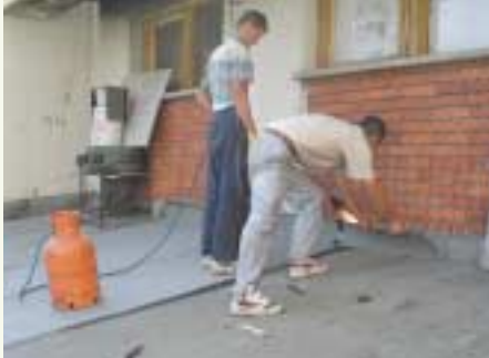
Die wichtigsten Sanierungsarbeiten konnten vor Wintereinbruch abgeschlossen werden.
